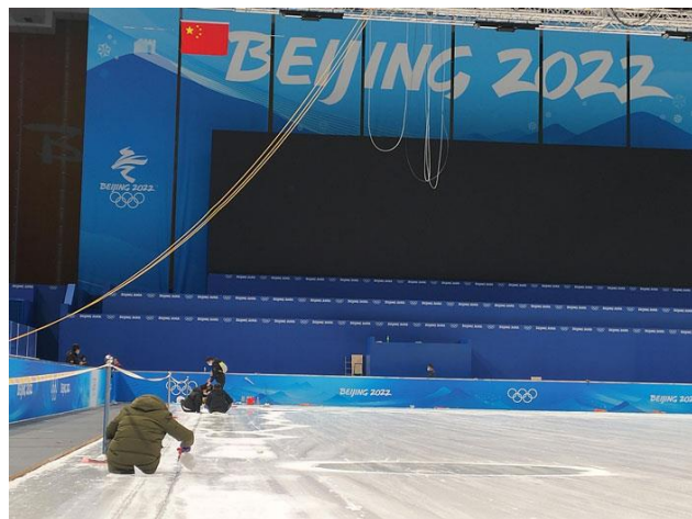
在“冰立方”冰壶赛场铺设用于冰体温度监测的通讯光纤
